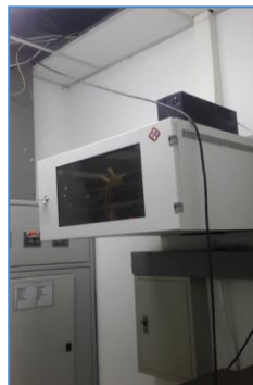
ภาพที่ 62 อุปกรณ์ห้องไฟฟ้าชั้น 1 ที่มา : ภาพผลการเก็บข้อมูล วันที่ 10 สิงหาคม 2560
