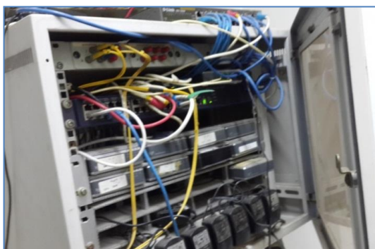
ภาพที่ 121 อุปกรณ์ห้องไฟฟ้าชั้น 1 สถาบันวิจัยและพัฒนา ที่มา : ภาพผลการเก็บข้อมูลตู้อุปกรณ์ วันที่ 19 สิงหาคม 2560
