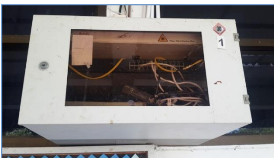
ภาพที่ 43 อุปกรณ์ตู้เครือข่ายอาคาร1 ที่มา : ภาพอุปกรณ์เครือข่าย วันที่ 8 สิงหาคม 2560
