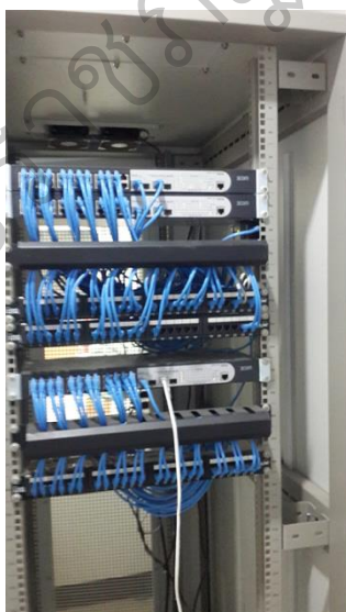
ภาพที่ 108 อุปกรณ์อาคาร A ที่มา : ภาพอุปกรณ์เครือข่าย วันที่ 19 สิงหาคม 2560
