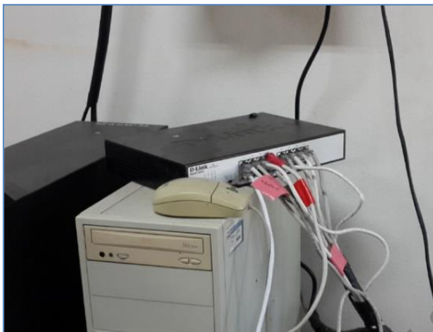
ภาพที่ 54 อุปกรณ์ตู้เครือข่ายอาคารวิทยสโมสร (ประจำชั้น1-2-3-4) ที่มา : ภาพผลการเก็บข้อมูล วันที่ 10 สิงหาคม 2560
