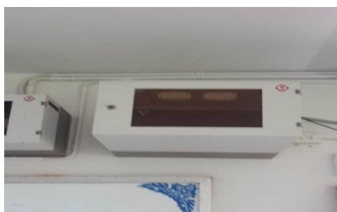
ภาพที่ 40 อุปกรณ์ตู้เครือข่ายอาคาร 4 ที่มา : ภาพอุปกรณ์เครือข่าย วันที่ 8 สิงหาคม 2560
