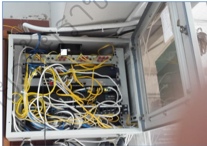
ภาพที่ 26 อุปกรณ์เครือข่ายอาคารอาคารปกเกล้า
