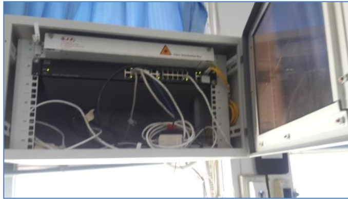
ภาพที่ 44 อุปกรณ์ตู้เครือข่ายอาคาร 2 ที่มา : ภาพอุปกรณ์เครือข่าย วันที่ 8 สิงหาคม 2560
