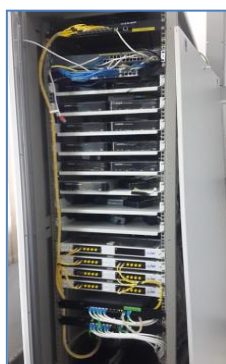
ภาพที่ 127 อุปกรณ์ห้องเครือข่ายอาคารที่ปวิชญ์ ชั้น1
