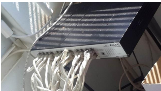
ภาพที่ 41 อุปกรณ์เครือข่ายอาคาร ที่มา : ภาพอุปกรณ์เครือข่าย วันที่ 8 สิงหาคม 2560
