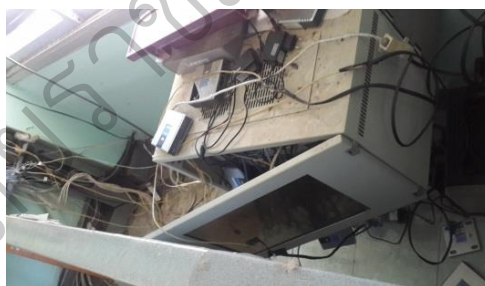
ภาพที่ 39 อุปกรณ์ห้องสมุดอาคาร 2 ที่มา : ภาพอุปกรณ์เครือข่าย วันที่ 8 สิงหาคม 2560
