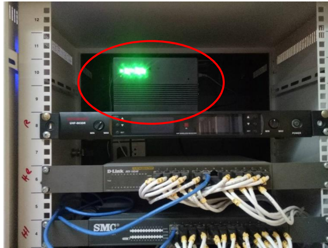
รูปที่ 3.12 แสดงภาพการออกแบบจำลองการติดตั้ง Node MCU Server
